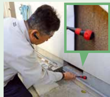
④壁や基礎に亀裂がないか確認
